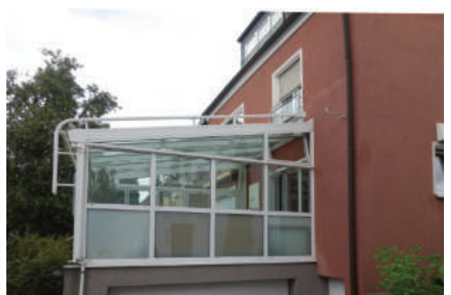
Beispiel: Überformung „Anbau“
