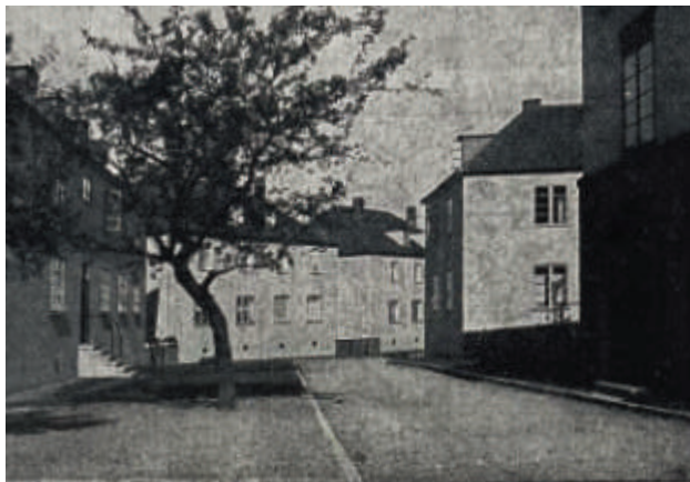
Gebäudevorzone am Waldsaum zur Bauzeit (Quelle: Stadt Essen)
