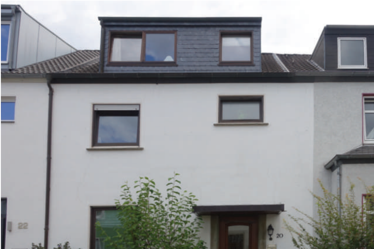
Beispiel: Überformung „Dachgauben“
