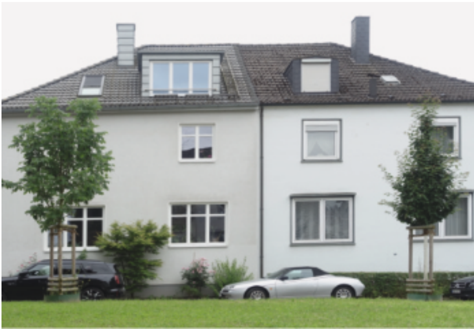
▶ Rechteckiges Doppelhaus mit seitlicher Erschließung am Grünhof.
