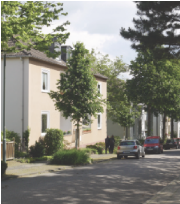
▲ Breitere Gebäude in offener Bauweise ergeben eine klare Straßenflucht mit rhythmisierter Abfolge entlang der Angerstraße.
