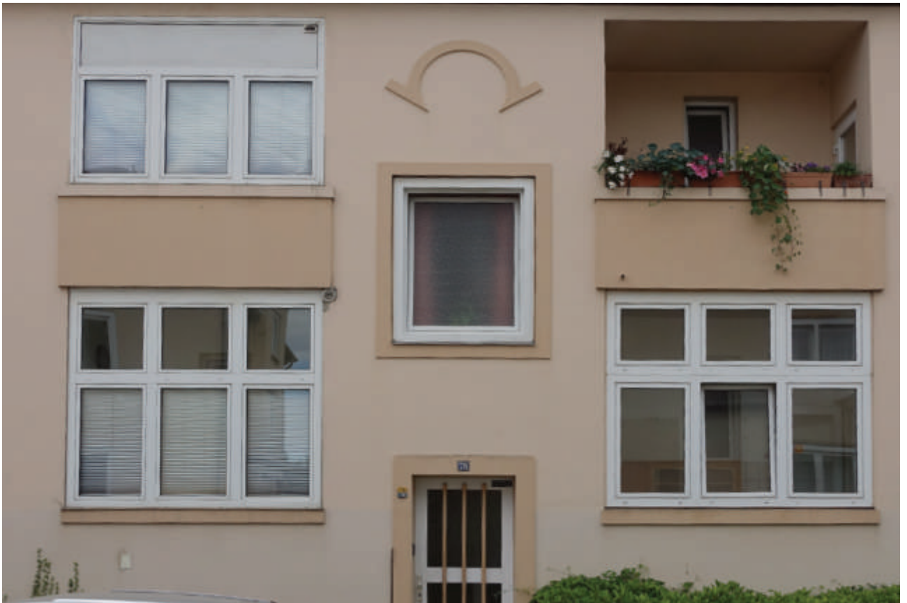
Beispiel: Überformung „Loggien“
