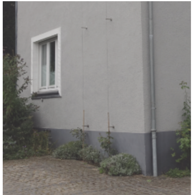
▲ Durch Ranksysteme kann Fassadenbegrünung gezielt platziert und Schäden vermieden werden.
