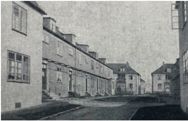
Blick auf die Bebauung im Waldblick zur Bauzeit (Quelle: J. Rings 1923)
