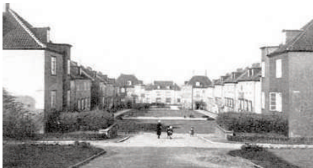
Blick in den Grünhof zur Bauzeit (Quelle: Stadt Essen)
